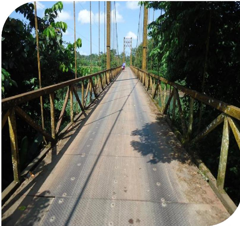
Reparación de cables de nivelación con la respectiva tensión, Puente sobre Río San Rafael, Horquetas.
